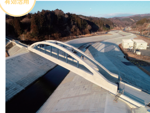
JR気仙沼線桜川橋梁(宮城県南三陸町) (橋桁、アーチ部、縦鋼にCfFA®使用)
